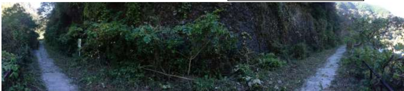
北山第二トンネル南 草刈 After
