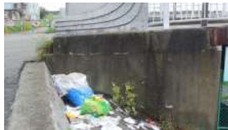
神津大橋東詰めの不法投棄ごみ
